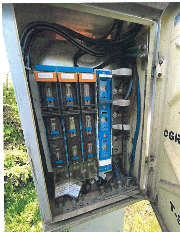
Istniejąca rozdzielnica do demontażu
